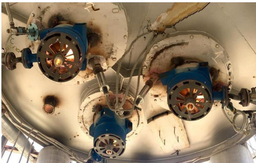
**Характеристика горелок ГФРК со встроенными мазутными форсунками ФПЖ-1**
